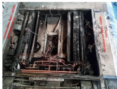
Fig. 4 – Ventilatoarele dublu radiale ale automotorului AM Desiro 2114
