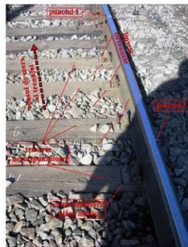
foto nr.8 - firul exterior al curbei - starea tehnică a traversilor între punctele 1-2 nu permite strângerea tirfoanelor pentru împiedicarea deplasării plăcilor metalice
