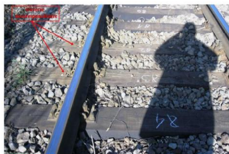
foto nr.3 - traverse necorespunzătoare între traverse noi
