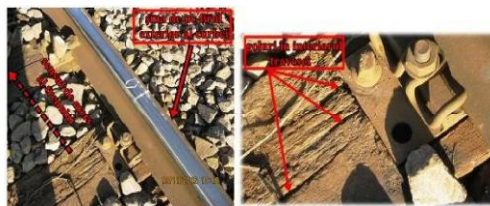
foto nr.7 - traversa din punctul 0 - capătul din partea dreaptă (firul exterior al curbei) și detaliu
