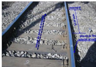
foto nr.1 - poziția punctului 0 față de două joante de capăt JIL-ului
