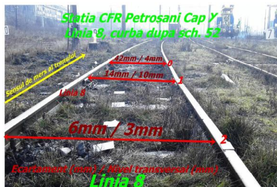
Foto 3. Valorile ecartamentului și nivelului transversal al căii în zona producerii deraierii
